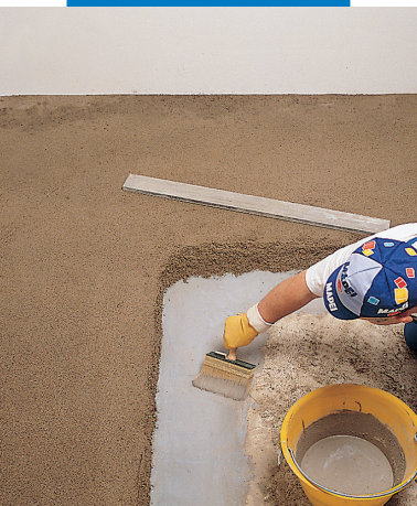
Auftragen der Haftbrücke bei Verbundestrichen
