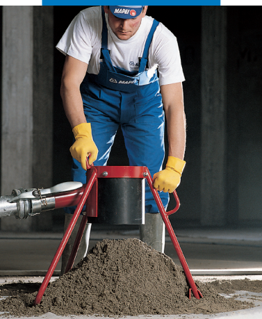
Förder des Topcem-Estrichmörtels mittels Estrichpumpe
