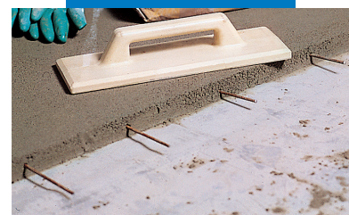
Topcem-Estrich-Verdübelung im Bereich der Arbeitsfugen
