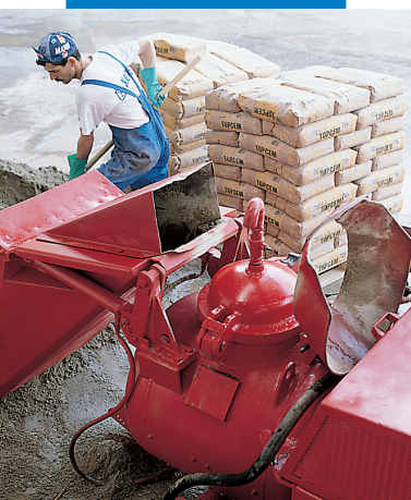
Anmischen von Topcem mithilfe einer automatischen Pumpeinheit
