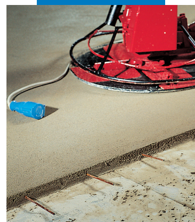
Oberflächenbehandlung des Topcem-Estrichs mittels Flügelglätter
